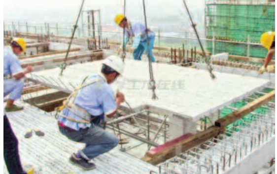
Thi công nhà tiền chế.
