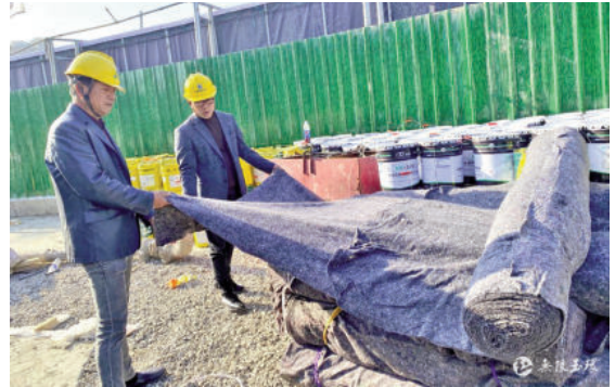
Trải bạt che cách nhiệt cho công trường xây dựng
