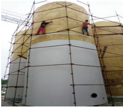
Bọc cách nhiệt các bể chứa bê tông
