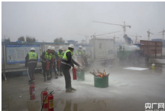
Diễn tập phòng cháy chữa cháy trên công trường trong điều kiện mùa đông
