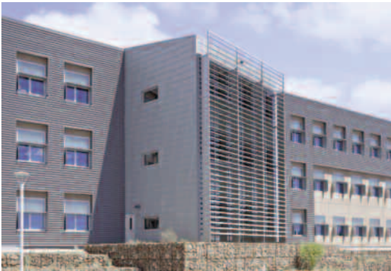
Lam che nắng cố định như tấm chắn nắng brise-soleil (giải pháp chống nắng ở vùng khí hậu nóng, số giờ nắng nhiều) của AGS giúp chặn hoặc phản chiếu ánh sáng mặt trời.
