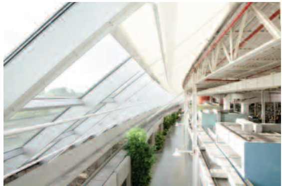
Lam che năng động của Mermet USA sử dụng công nghệ cảm biến ánh sáng mặt trời để hạ xuống và thu vào theo chuyển động của mặt trời.
