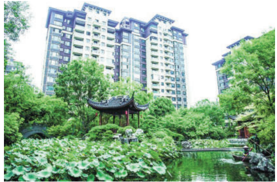
Shengbang Binjiang Mansion áp dụng khái niệm xây dựng thành phố bọt biển để sử dụng nước mưa thu được cho các cảnh quan vùng nước trong cộng đồng
