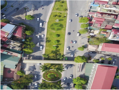
Các dải phân cách giữa đường, các đảo dừng chân an toàn là một phần trong cấu trúc mạng lưới đường bộ đô thị
