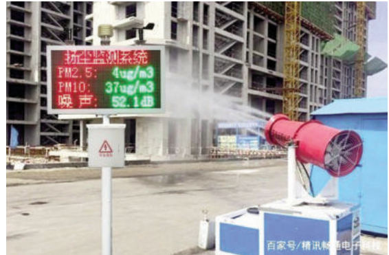
Hệ thống quan trắc giám sát bụi, khí thải và tiếng ồn trực tuyến trên công trường
