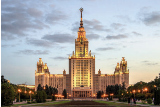
Tòa nhà Trường ĐH tổng hợp quốc gia Lomonosov Moskva - 1 trong 7 tòa tháp chọc trời được xây dựng dưới thời Stalin, đặc trưng bởi đỉnh tháp nhọn có ngôi sao trên đỉnh
