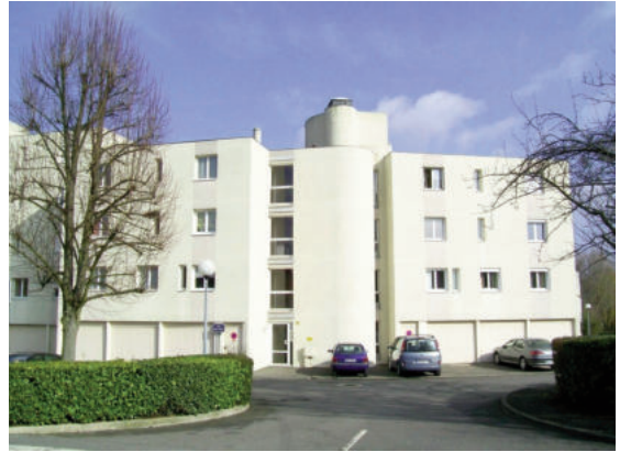
Dự án nhà xã hội Jardin Frémin ở Surveilliers, Val-d'Oise, Ile de France
