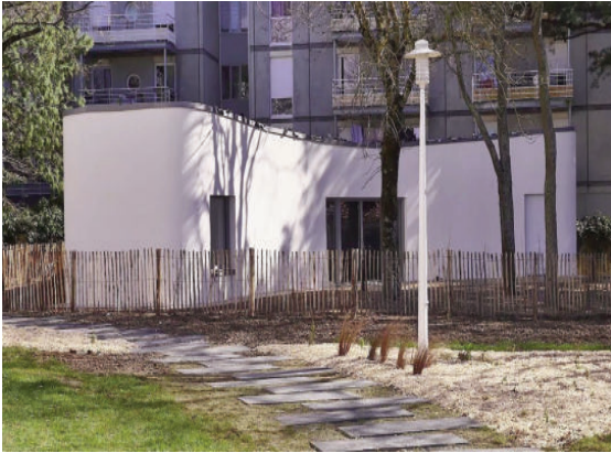
Nhà xã hội đầu tiên được xây bằng công nghệ 3D tại thành phố Nantes
