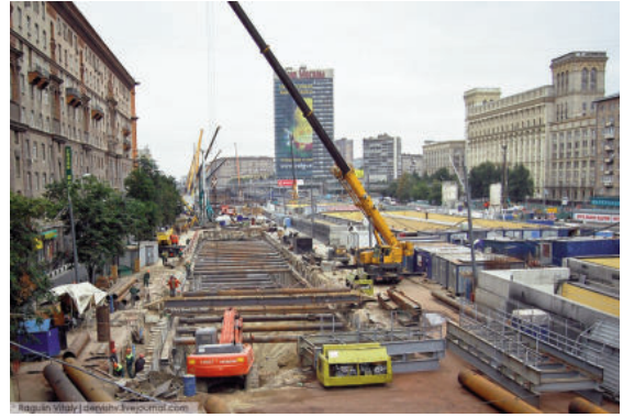
Thi công đường hầm Alabyano - Baltic tại trung tâm Moskva
