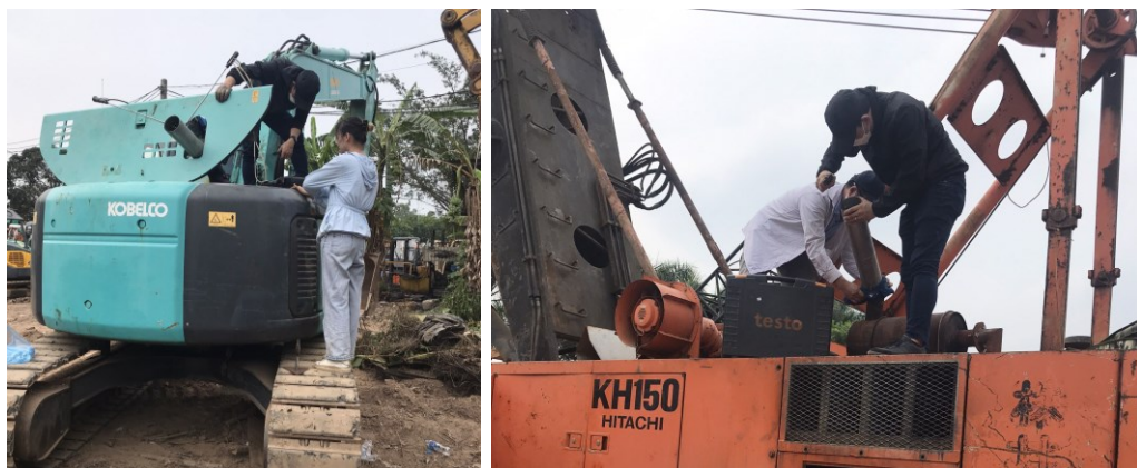
Hình 2.5. Hình ảnh lắp đặt thiết bị đo cho máy đào
