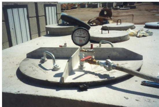
Hình 2.14. Kiểm tra độ kín khít của bể tự hoại BTCT đúc sẵn bằng phương pháp hút chân không (Nguồn: Buchman C., 2005)
