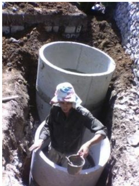
Hình 2.6. Thi công xây dựng bể tự hoại bằng ống cống BTCT đúc sẵn
