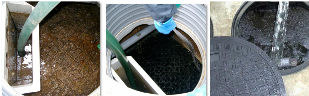
Hình 4.2. Hút bùn, tẩy rửa giá thể vi sinh cho bể xử lý nước thải.
