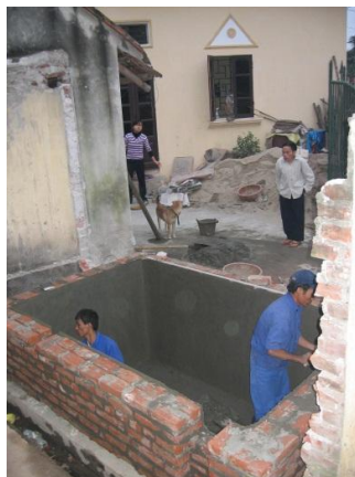
Hình 2.3 Xây dựng bể tự hoại bằng gạch ở ngoại thành Hà Nội
