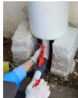
c) Gắn van đáy xả nước mưa đợt đầu
