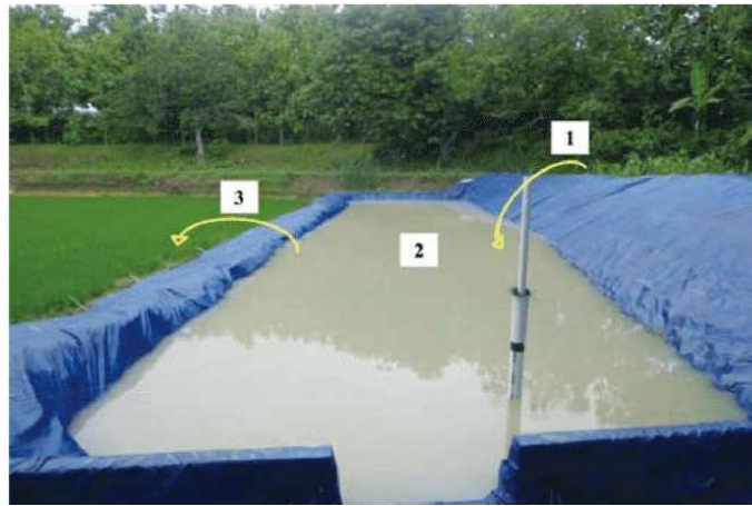
Hình 1.7. Ao chứa nước mưa sử dụng trong nông nghiệp phổ biến ở các nước Đông Nam Á 11 (1: Thu nước mưa từ bề mặt và ao; 2: Ao chứa nước mưa; 3: Nước mưa được sử dụng cho ruộng lúa)
