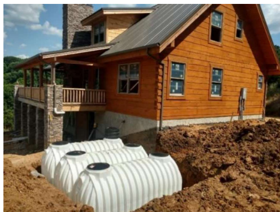
Hình 1.6. Bể chứa nước mưa để cấp nước sinh hoạt tại Ohio (Mỹ)
