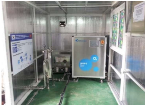
Hình 1.32. Hệ thống xử lý nước mưa thành nước uống trực tiếp
