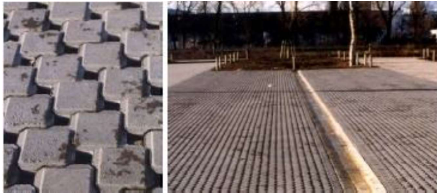
Hình 4.5. Vỉa hè thấm nước
