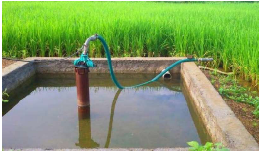
Hình 1.11. Thu gom nước mưa để bổ cập giếng nước ngầm mạch nông và bơm cấp nước tưới ở Ấn Độ 13
