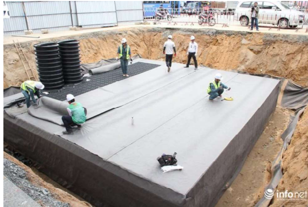
Hình 4.23. Thi công lắp đặt bể ngầm chứa nước mưa theo công nghệ Crosswave tại TP. HCM
