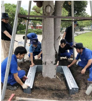
Hình 1.39. Lắp đặt mô-đun với các hộp thu giữ nước mưa và thấm dần, cấp nước tưới cho cây xanh ở thị xã Phú Mỹ, Bà Rịa – Vũng Tàu 26
