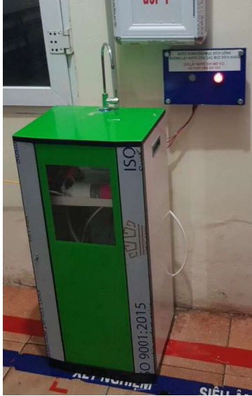
Hình 2.34. Cột lọc nước nhiều bậc và đèn khử trùng bằng UV
