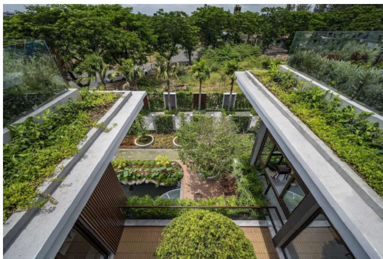
Hình 2.42. Sử dụng nước mưa để tưới mái nhà xanh và bổ cấp cho bể nuôi cá
