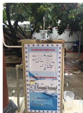
Hình 1.38. Hệ thống thu gom và xử lý nước mưa tại Chùa Phương Nại, Ninh Bình
