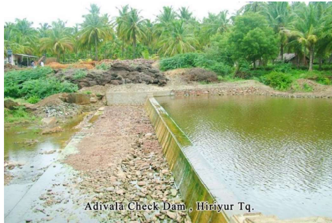
Hình 1.8. Đập ngăn để trữ nước mưa ở Ấn Độ 12
