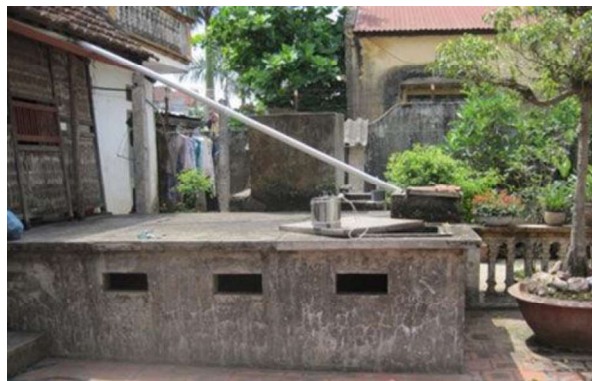
Hình 1.24. Bể chứa nước mưa xây bằng gạch ở hộ gia đình vùng nông thôn Việt Nam
