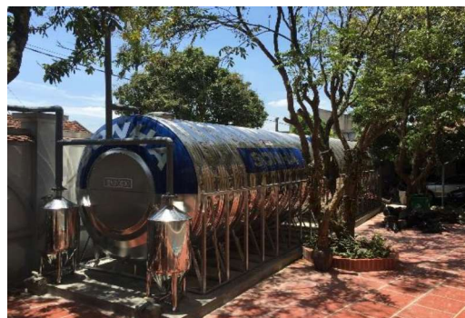
b/ Hệ thống bể chứa nước mưa
