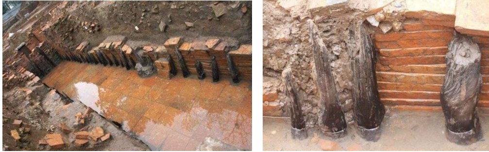
Hình 1.21. Rãnh thoát nước mưa lớn thời Lý được phát hiện tại Hoàng Thành Thăng Long
