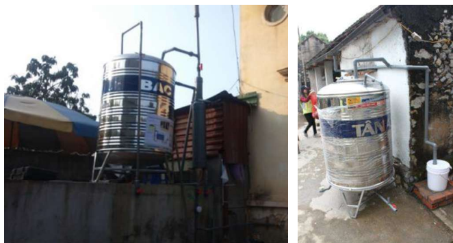
Hình 1.28. Các hệ thống thu gom nước mưa cấp nước ăn uống tại Kim Bảng, Hà Nam
