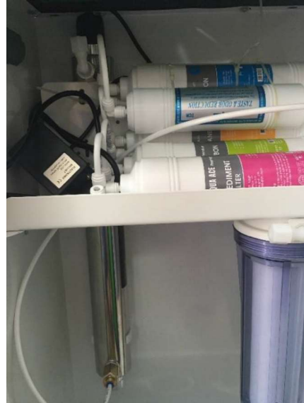
Hình 2.34. Cột lọc nước nhiều bậc và đèn khử trùng bằng UV
