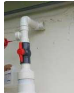
d) Lắp đặt thiết bị lọc thô
