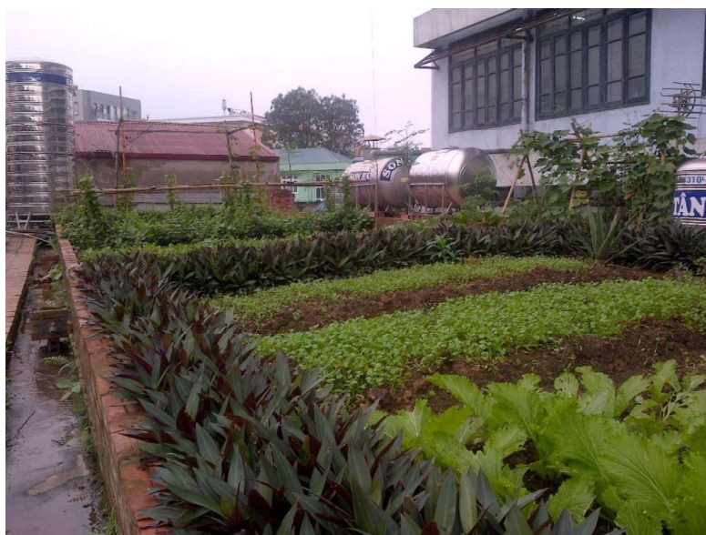
Hình 2.43. Mái nhà xanh sử dụng nước mưa tại Trường ĐHXDHN
