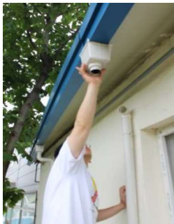
a) Lắp đặt xê-nô và kiểm tra mái thu
