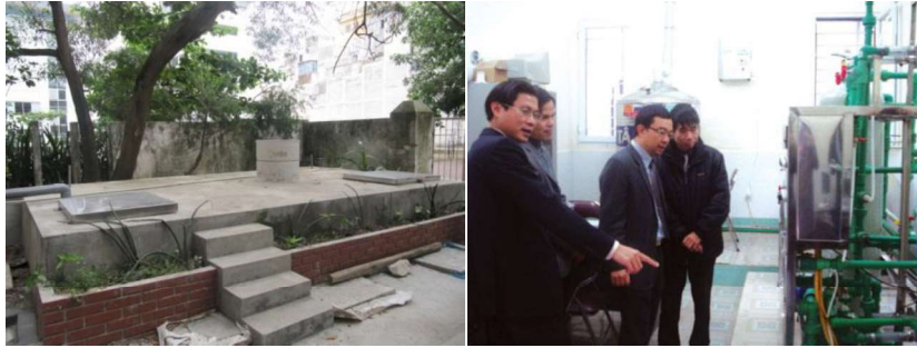
Hình 4.3. Bể chứa và hệ thống xử lý nước mưa tại Trường Đại học Xây dựng Hà Nội
