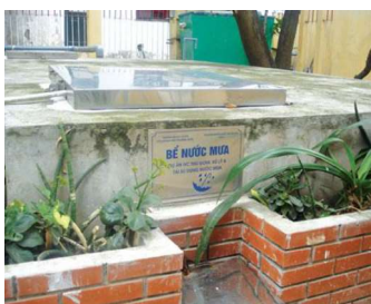
d) Bể bê-tông cốt thép
