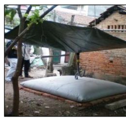
f) Lắp túi nước mưa plastic
