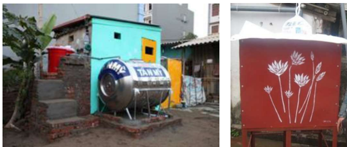
Hình 1.27. Hệ thống thu gom nước mưa cấp nước ăn uống tại Cự Khê, 2010
