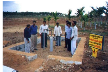
Hình 1.11. Thu gom nước mưa để bổ cập giếng nước ngầm mạch nông và bơm cấp nước tưới ở Ấn Độ 13
