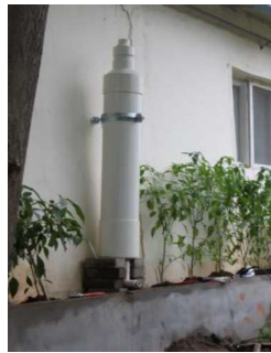
b) Lắp đặt ống tách nước mưa đợt đầu
