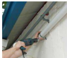
g) Lắp đặt đường ống
