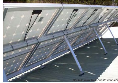
Hình 72. Cấu tạo khung liên kết nâng đỡ hệ tấm pin năng lượng mặt trời
