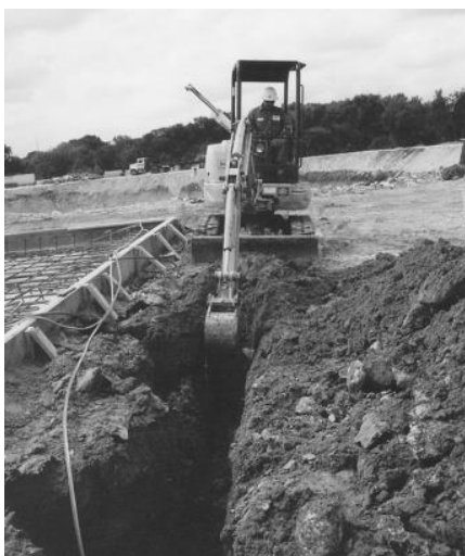
Hình 3.7. Trên thực tế thi công cần có thiết bị chuyên dụng (trong ảnh thi công đào rãnh tiếp đất)
