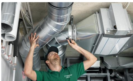
Hình 6.1 – Công tác làm sạch đường ống dẫn không khí và bộ lọc 7
