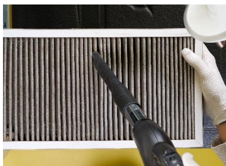
Hình 6.1 – Công tác làm sạch đường ống dẫn không khí và bộ lọc 7
