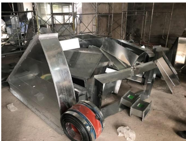
Hình 5.1 — Khu vực chứa các đường ống dẫn không khí của hệ thống HVAC không được bảo vệ ở công trường
