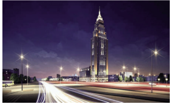
Chiếu sáng kiến trúc tổ hợp căn hộ Alcon Tower tại Moskva
