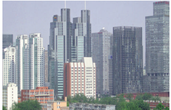
Xây dựng nhà ở tại Trung Quốc
