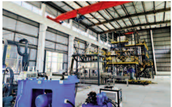
Dây chuyền thử nghiệm vật liệu xây dựng mới.
