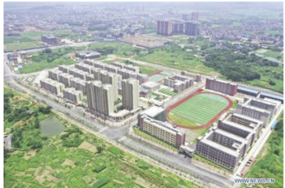
Khu nhà tái định cư cho người nghèo ở huyện Hưng Nghiệp, Khu tự trị dân tộc Choang - Quảng Tây
