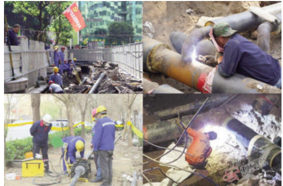
Việc cải tạo mạng lưới đường ống ngầm đô thị tại Trung Quốc đang được tiến hành ở nhiều nơi
