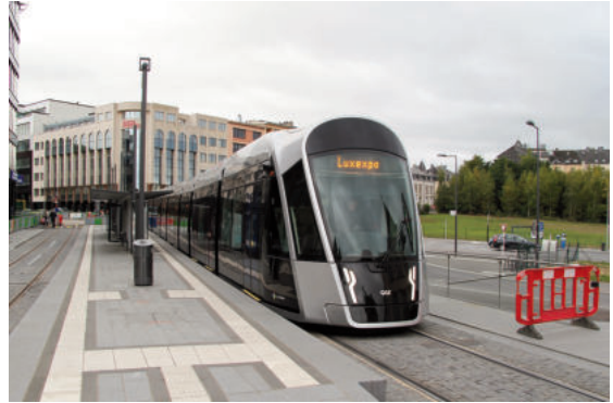
LRT - hệ thống vận chuyển hành khách công cộng hiện đại phổ biến tại các nước tiên tiến trên thế giới
