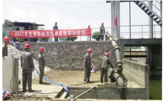
Lắp đặt đường ống thoát nước tại quận Nghi Tú, An Huy, Trung Quốc
