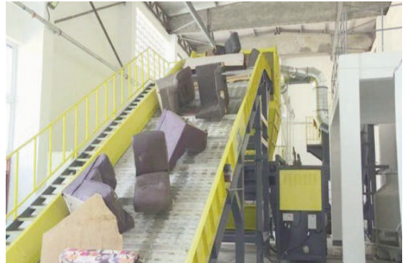
Rác quá khổ sau phân loại được băng tải xích đưa đến khu vực máy nghiền
