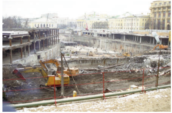
Thi công dự án trung tâm thương mại Okhotny Ryad tại trung tâm lịch sử Moskva
