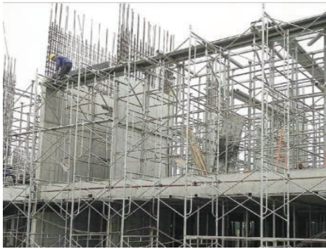
Giàn giáo Khung được sử dụng làm hệ bao che ngoài
