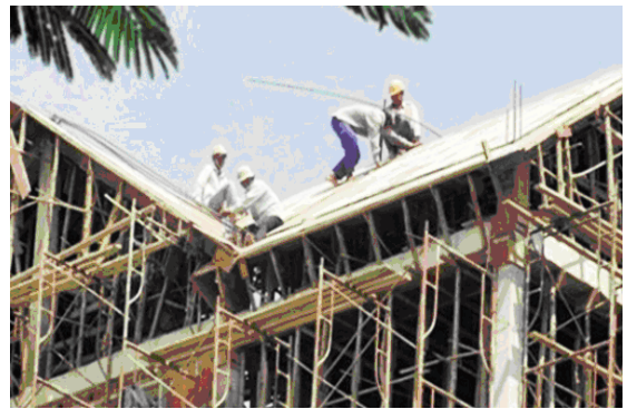
Công nhân thi công giàn giáo tại công trường
