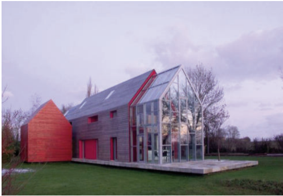
Nhà "trượt" - lớp vỏ có thể trượt đi trượt lại để che hoặc mở cho mặt tiền kính của ngôi nhà, giúp điều chỉnh ánh sáng, nhiệt độ trong nhà
